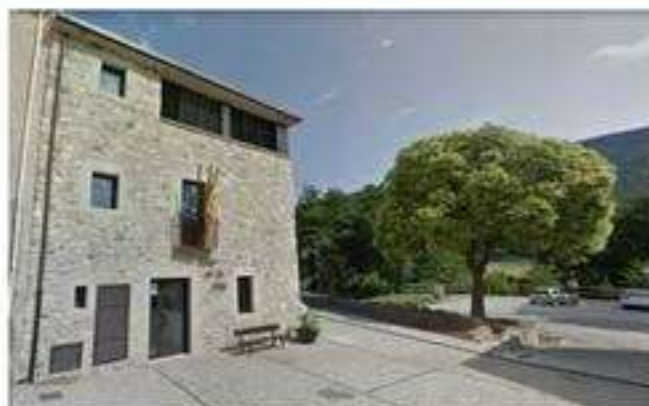
Ajuntament Sant Martí de Llémena Edifici consistorial (14 kW)
