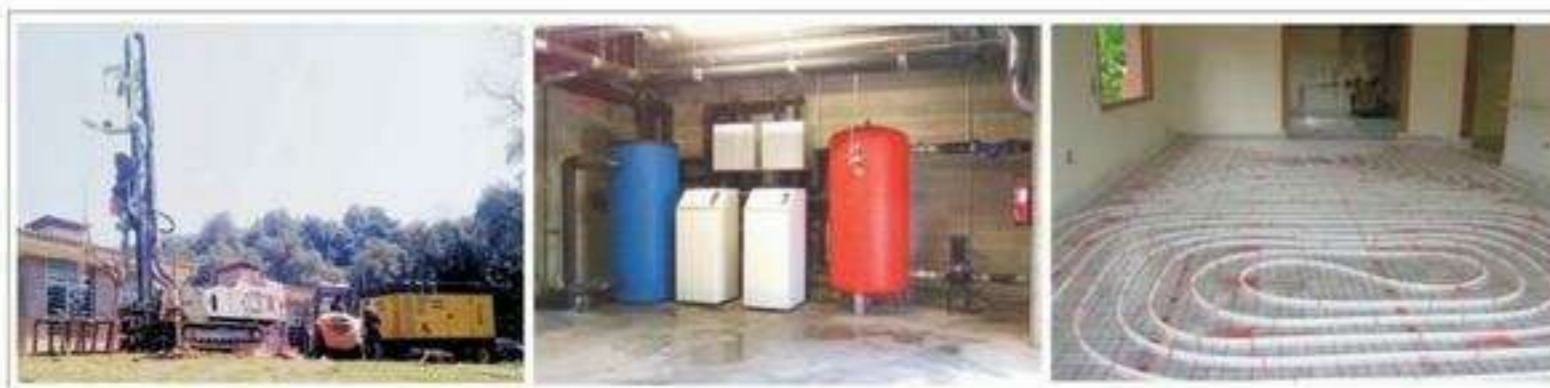
Camp de captació geotèrmica
