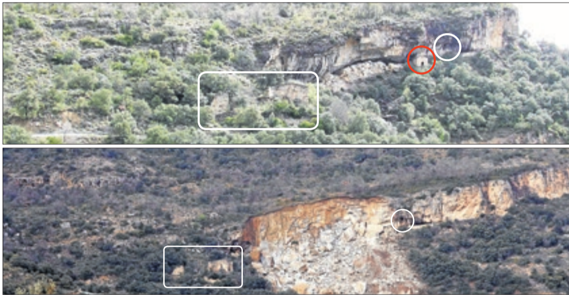
La imagen del talud antes del desprendimiento y abajo, después del alud del lunes.
