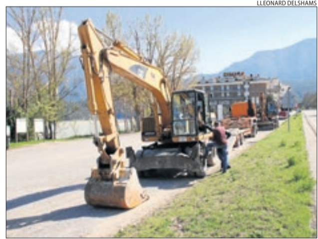
Las máquinas que adecuarán la vía alternativa.
