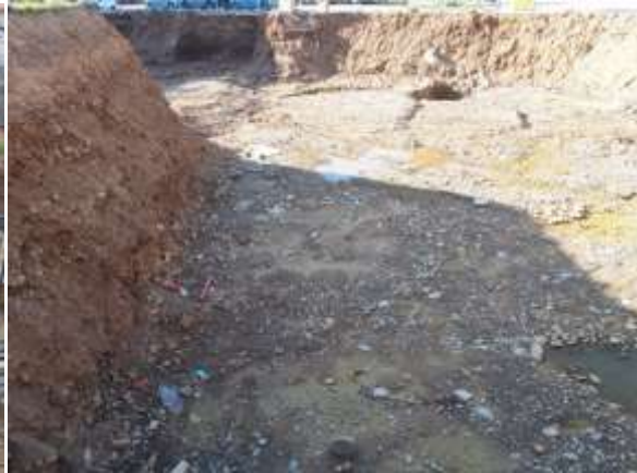
Figura 4.8. Obra 2, amb aigua Cruïlla Carretera de Dosrius-Av. Del ferrocarril; 12/06/19 (font pròpia)
