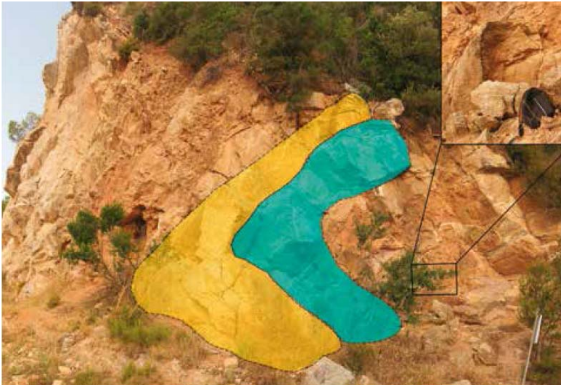
Figura 1.2. Vista del plec tombat i situació de la xarnera de la figura 1.1.
