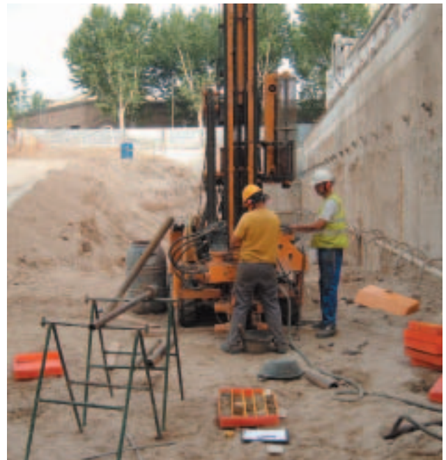
Execució de reconeixements del subsòl per a la realització d'un estudi geotècnic per a edificació.
